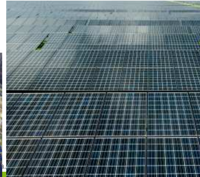
50 MW in China (Yingli modules)
